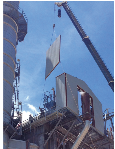
HRSG Enclosure Erection
